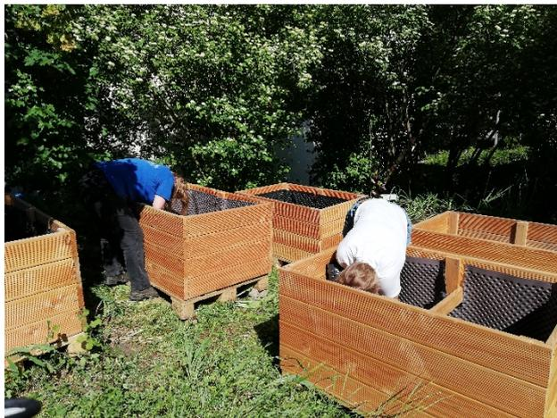
Damit die eingefüllte Erde später nicht vom Regen ausgeschwemmt wird, muss innen eine Kunststoffolie an die Holzwände angebracht und der Boden mit Vlies ausgelegt werden.
